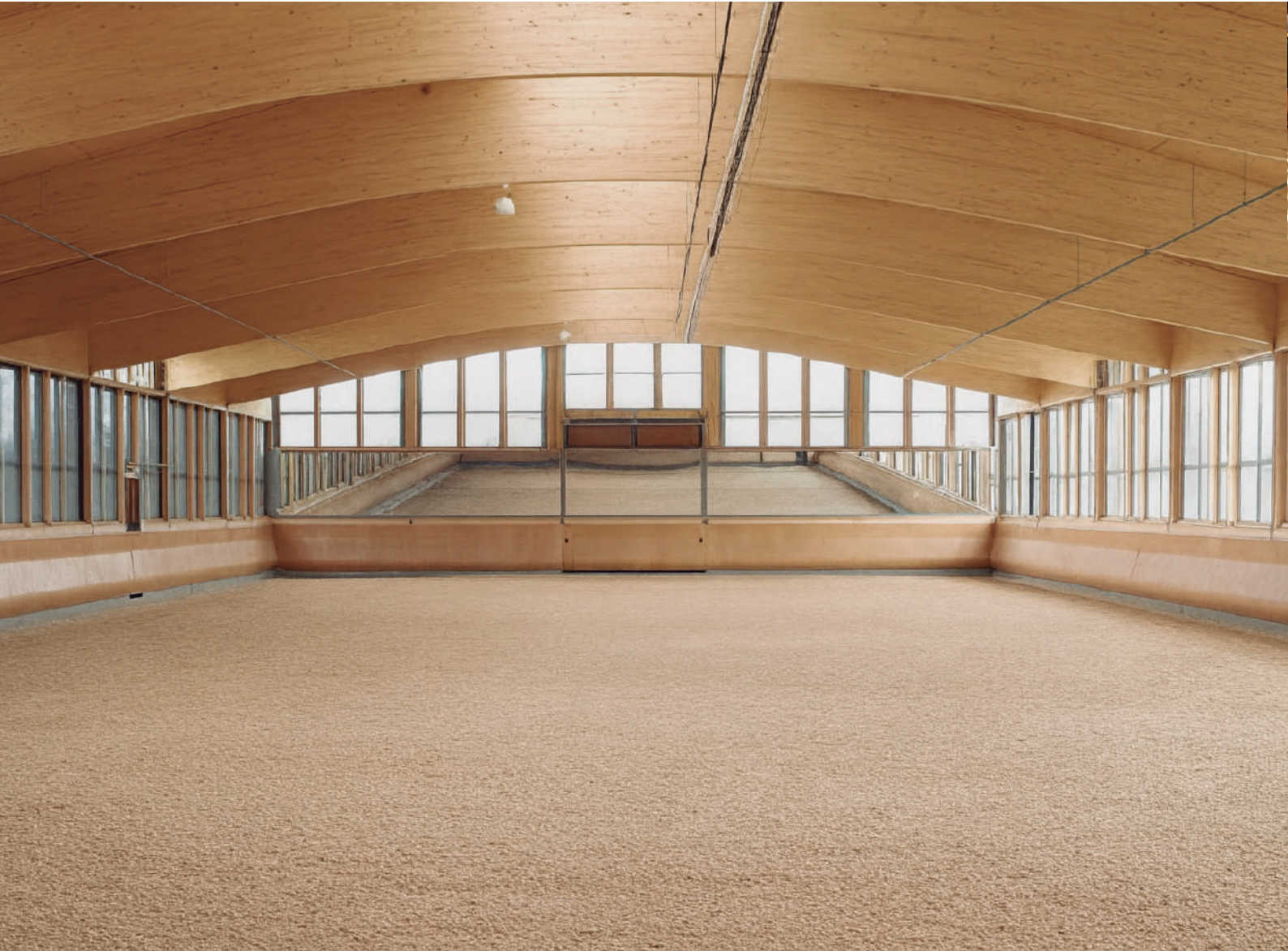
42 Pista interior con espejo Diamond system y guardabotas de madera.
