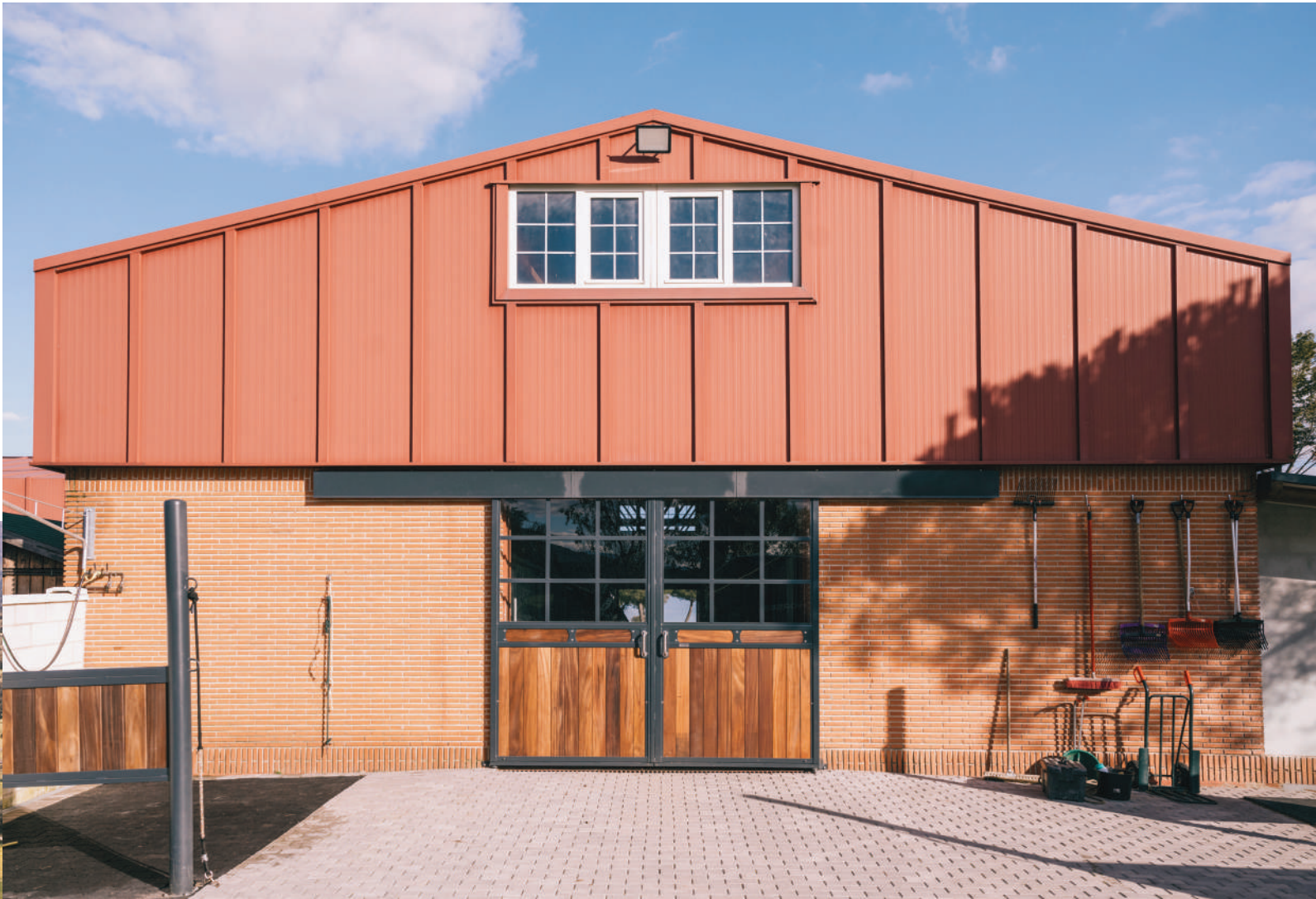
Entrada a nave con puerta corredera Smulders
