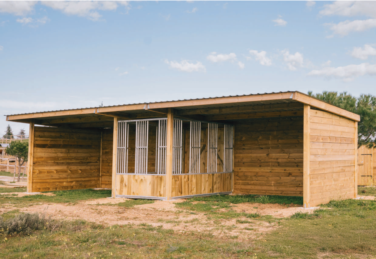
14 Refugio Nutriconfort con forrajera integrada
