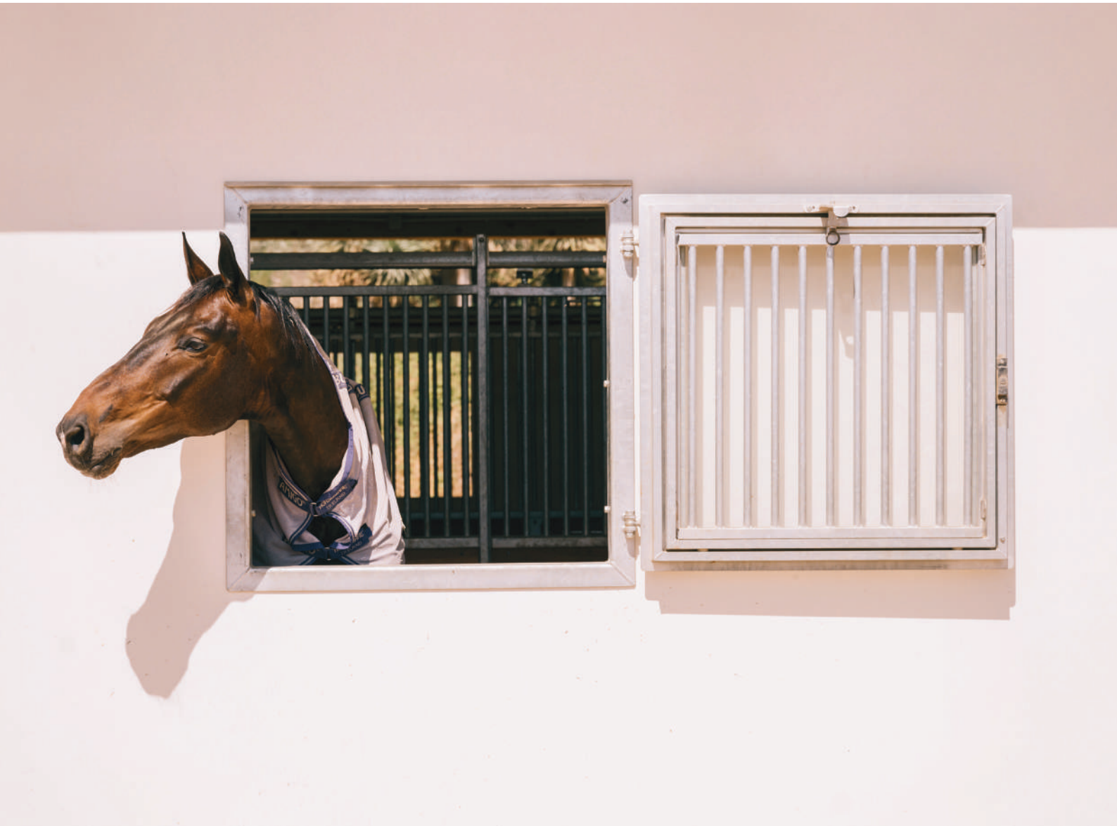
22 Ventana batiente con marco de acero galvanizado.
